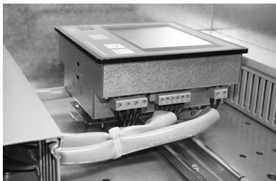
Abb. Leitungszuführung für das UMG505 auf Tragschiene
